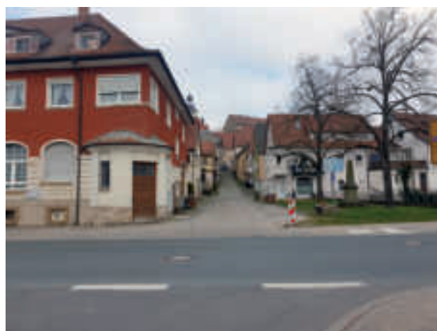
Fehlende Querung Wenzberg
