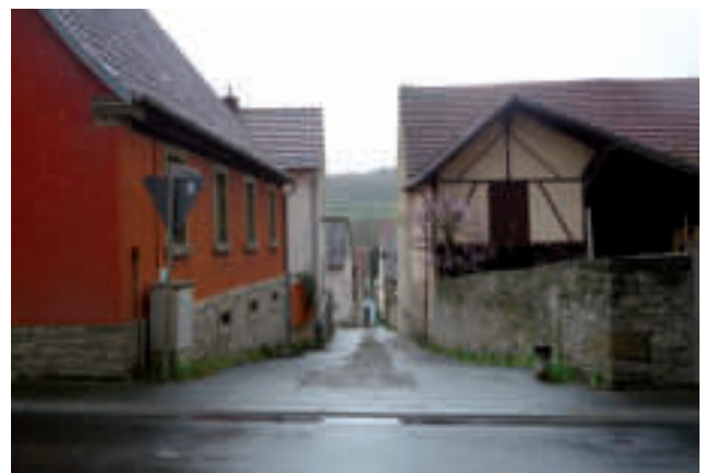
Gasse mit Sanierungsbedarf
