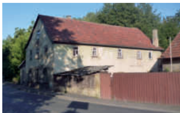
Sanierungsbedürftiges Anwesen in Heugrumbach
